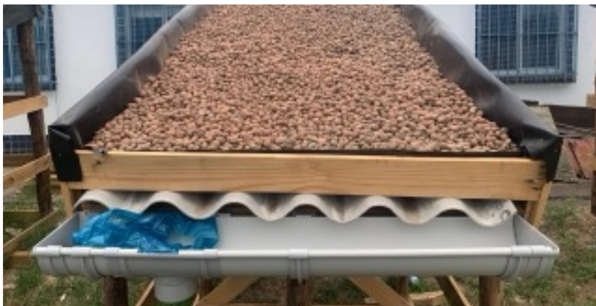
Figura 8. Protótipo 3 na etapa de colocação da argila expandida (Fonte: EcoClima)
