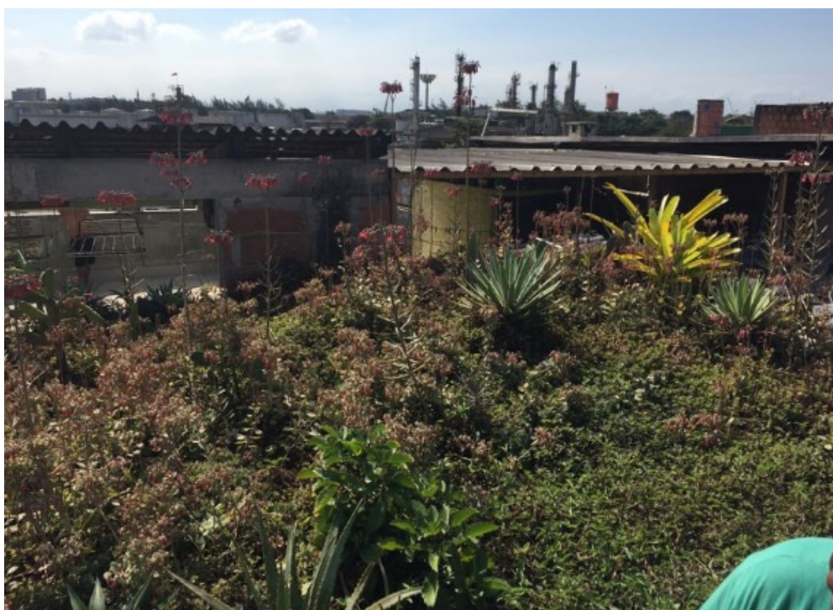
Figura 4. Telhado verde no ano de 2022 (EcoClima)
