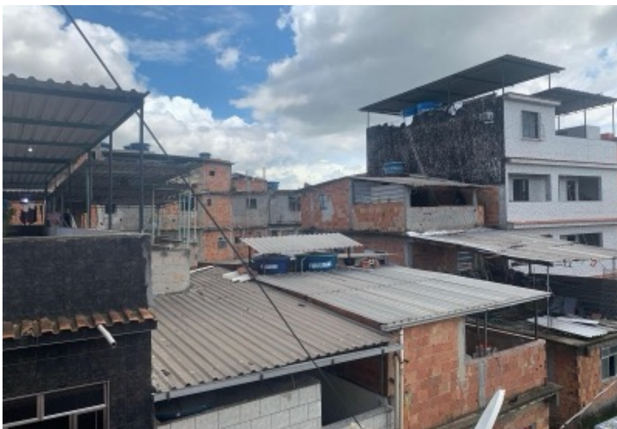
Figura 15. Vista parcial das coberturas da comunidade da Maré. (Fonte: EcoClima)
