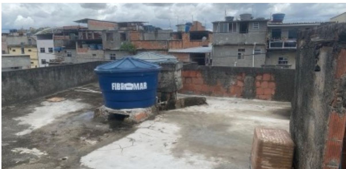
Figura 17. Casa com cobertura em laje (Fonte: EcoClima)
