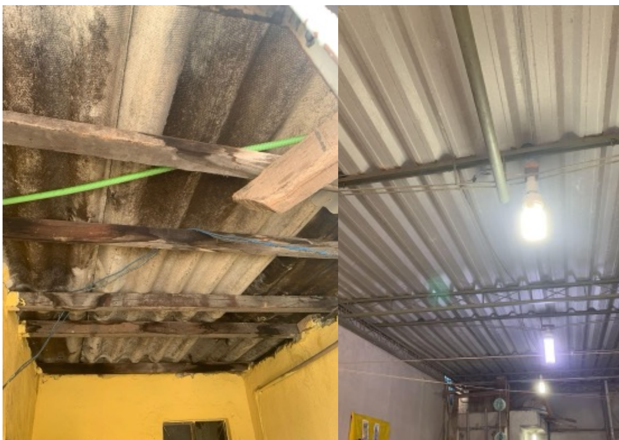
Figura 18 e 19. Casas com cobertura em telhas de fibrocimento (à esquerda) e metálica (à direita) (Fonte: Eco-Clima)
