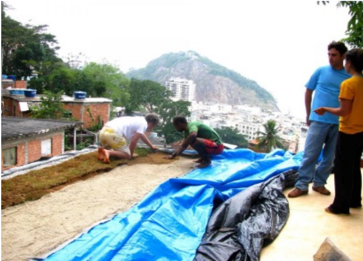
Figura 2. Execução das camadas do telhado verde (TIBÁ, 2008)
