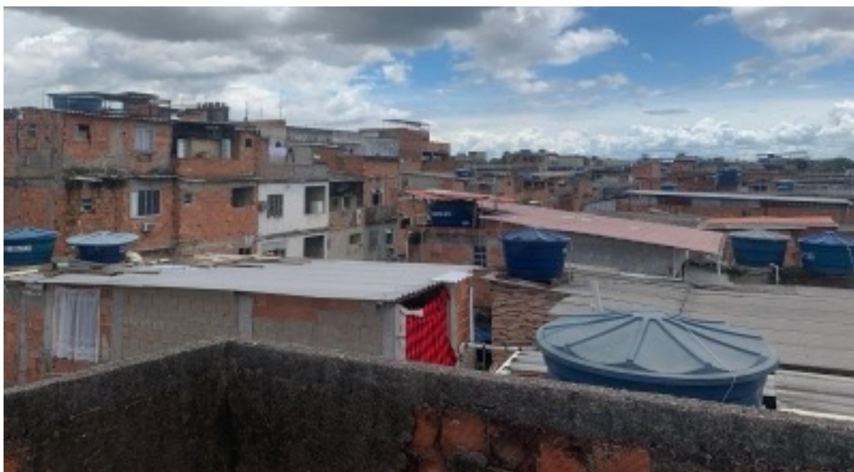
Figura 16. Vista das coberturas da comunidade da Maré. (Fonte: EcoClima)
