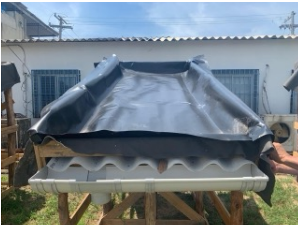
Figura 9. Protótipo 4 na etapa de colocação da geomembrana (Fonte: EcoClima)
