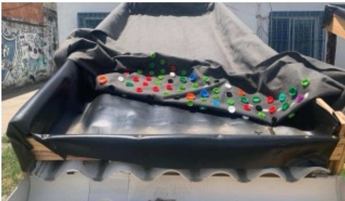
Figura 7. Protótipo 2 na etapa de colocação do geotêxtil (Fonte: EcoClima)
